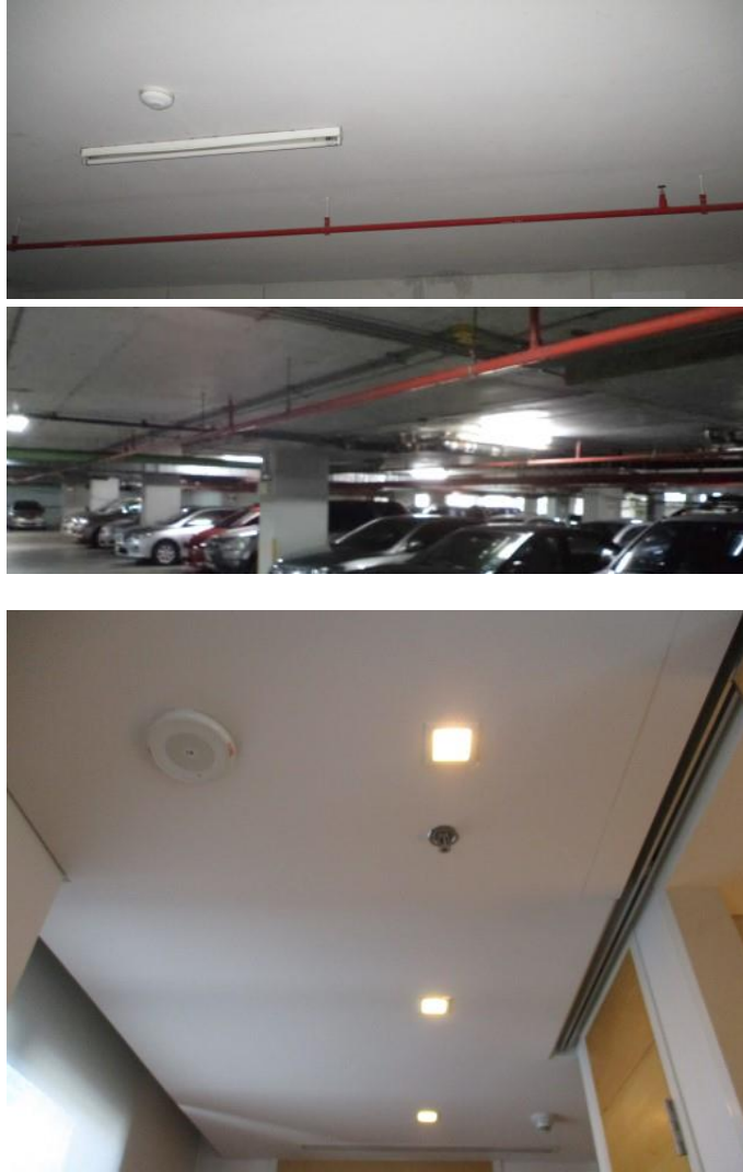
ภาพแสดง : หัวกระจายน้ำดับเพลิงอัตโนมัติ
